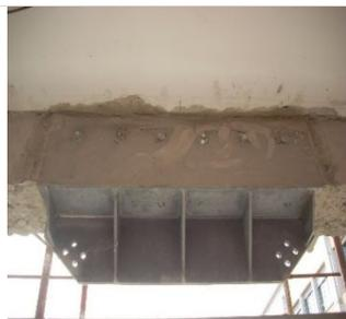
**Figura 19:** Piastra di collegamento controventi alla trave esistente
