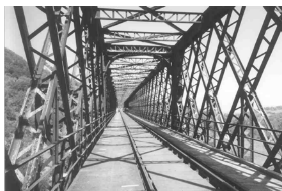
Fig. 12 La travata del ponte di Lapio.
