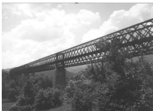
Fig. 11 - Il ponte di Lapio al km22.
