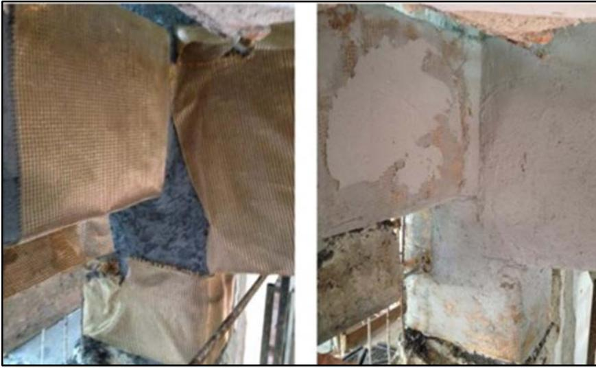
Figura 2.15 – Rinforzo di nodi travi-pilastro.
