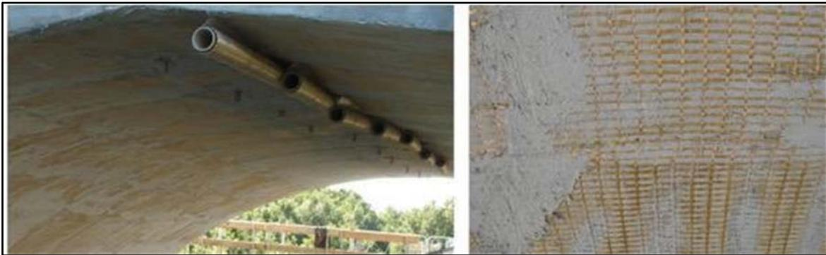
Figura 2.22 – Rinforzo intradossale di un ponte ad archi in calcestruzzo con reti di PBO.
