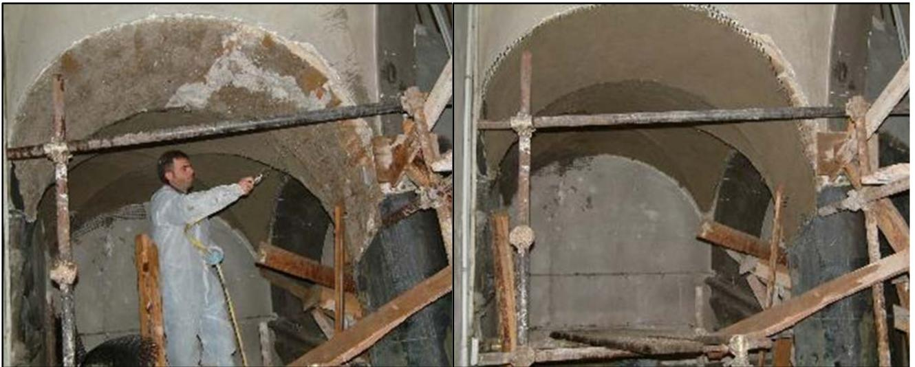
Figura 2.5 – Rinforzo intradossale di volta muraria con rete di fibra di vetro AR e malta.
