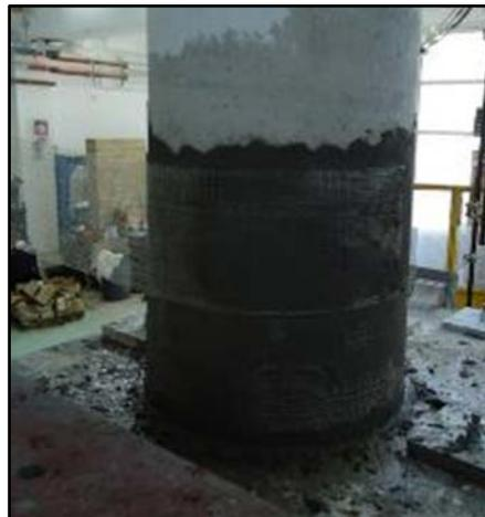
Figura 2.14 – Confinamento di pilastro con tessuto metallico galvanizzato unidirezionale e malta.
