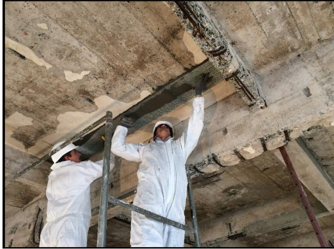
Figura 2.11 – Rinforzo a flessione di trave mediante placcaggio con strisce di tessuto unidirezionale realizzate con rete di acciaio galvanizzato ad altissima resistenza e malta cementizia.
