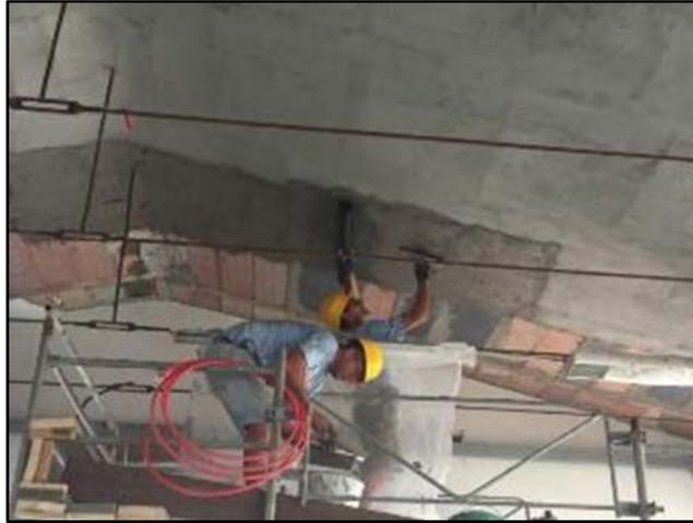
Figura 2.19 – Rinforzo di solaio (antifondellamento) con rete di fibra di vetro AR e malta.
