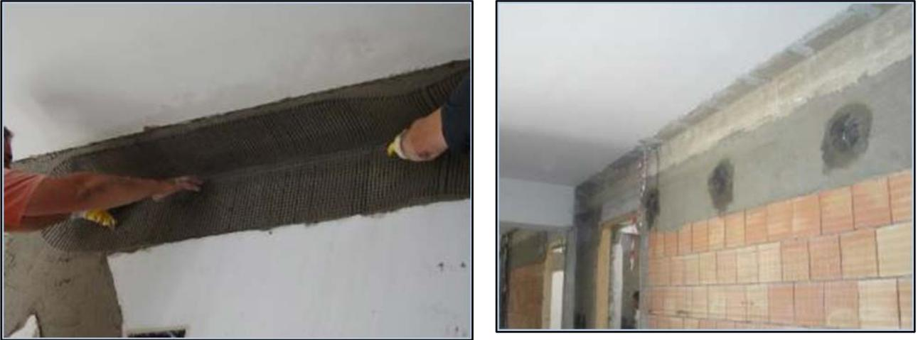
Figura 2.21 – Presidio antiribaltamento delle tamponature con diversi tipi di reti e connettori.
