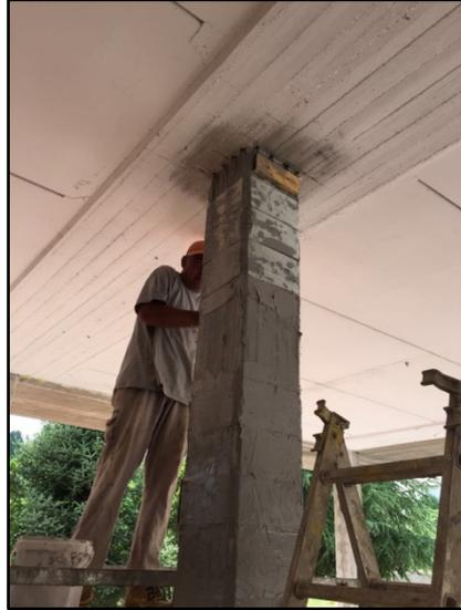
Figura 2.13 – Cerchiatura di pilastro mediante tessuto unidirezionale realizzato con rete di acciaio galvanizzato ad altissima resistenza e malta cementizia.
