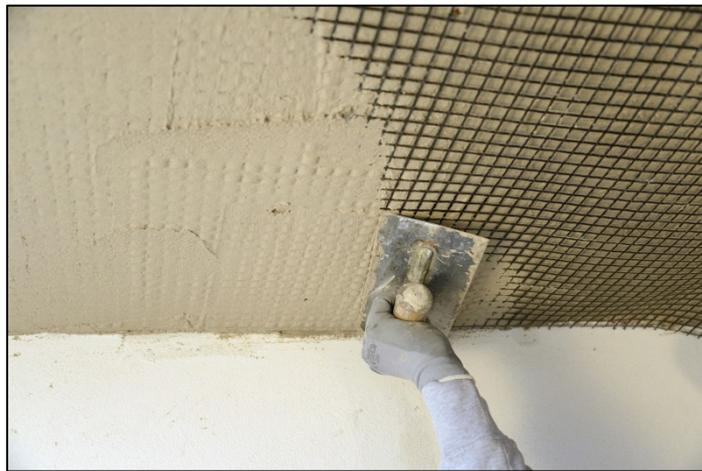
Figura 2.18 – Rinforzo di un solaio (antifondellamento).
